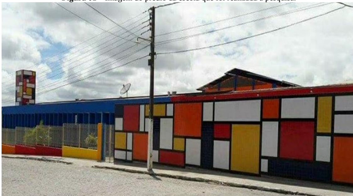
Figura 01 – Imagem do prédio da escola que foi realizada a pesquisa.
