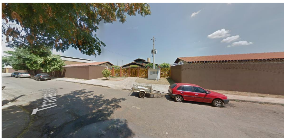
Figura 1 – Fachada do CETAN.
