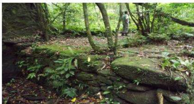
Figura 14 - Trilha das Ruínas (Fonte: Parnaso Tur 12 )
